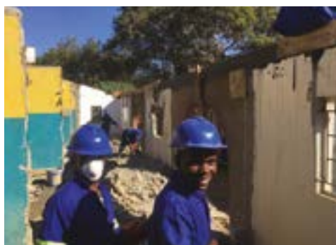
I lavori di rinnovamento.
