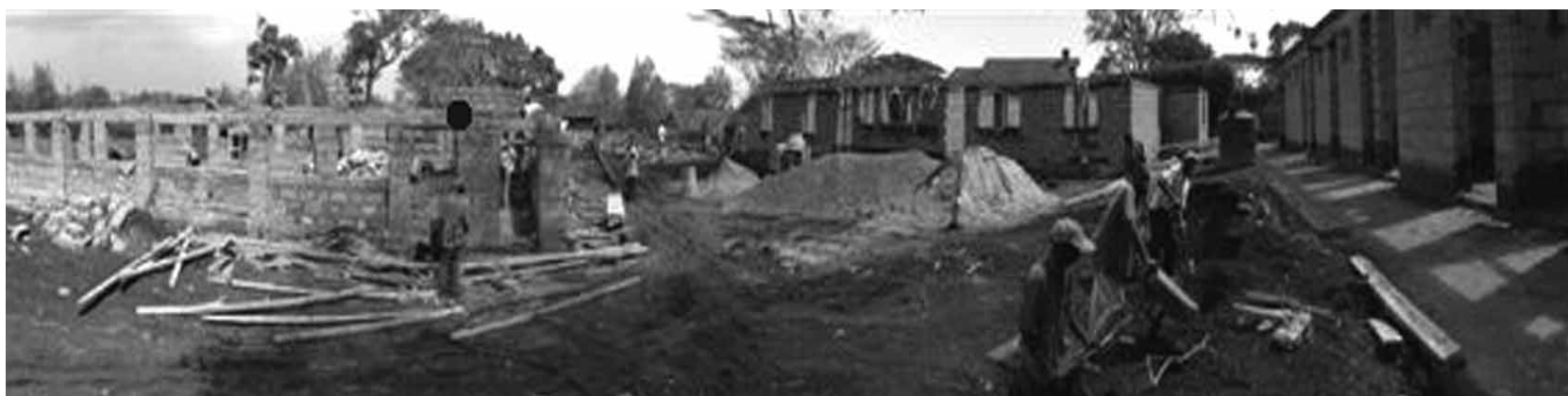
Fervono i lavori
